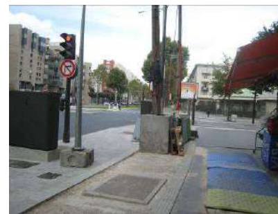
Installations du chantier tramway
