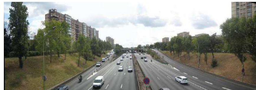
Vue du périphérique depuis la rue de Lagny
