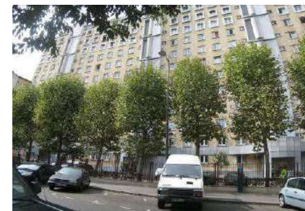
Immeubles de logements de la rue du Commandant l'Herminier
