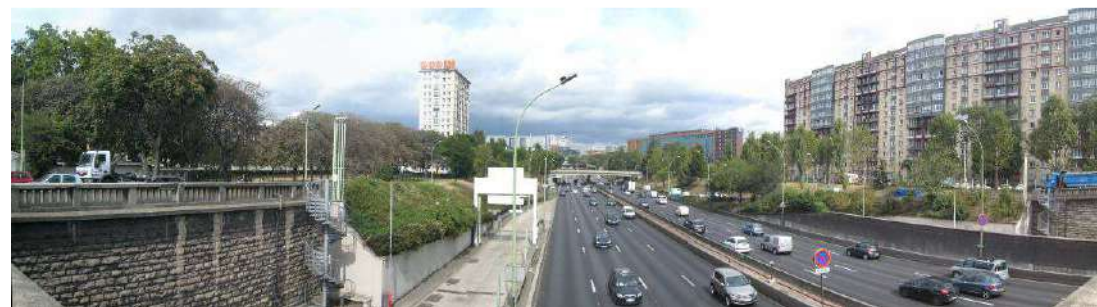
Vue du périphérique depuis la rue de Courteline
